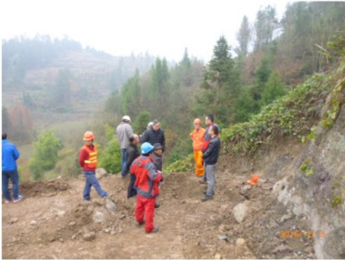
▶ 水土保持技术人员和参建各方责任主体现场解决存在的水保问题
