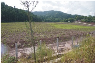
成都第二绕城高速公路东段项目
