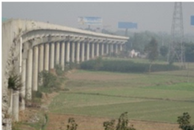
成都至绵阳高速公路项目
