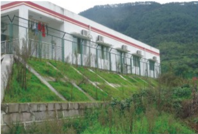
川渝地区天然气管网调整改造工程江津-纳溪输气管道工程
