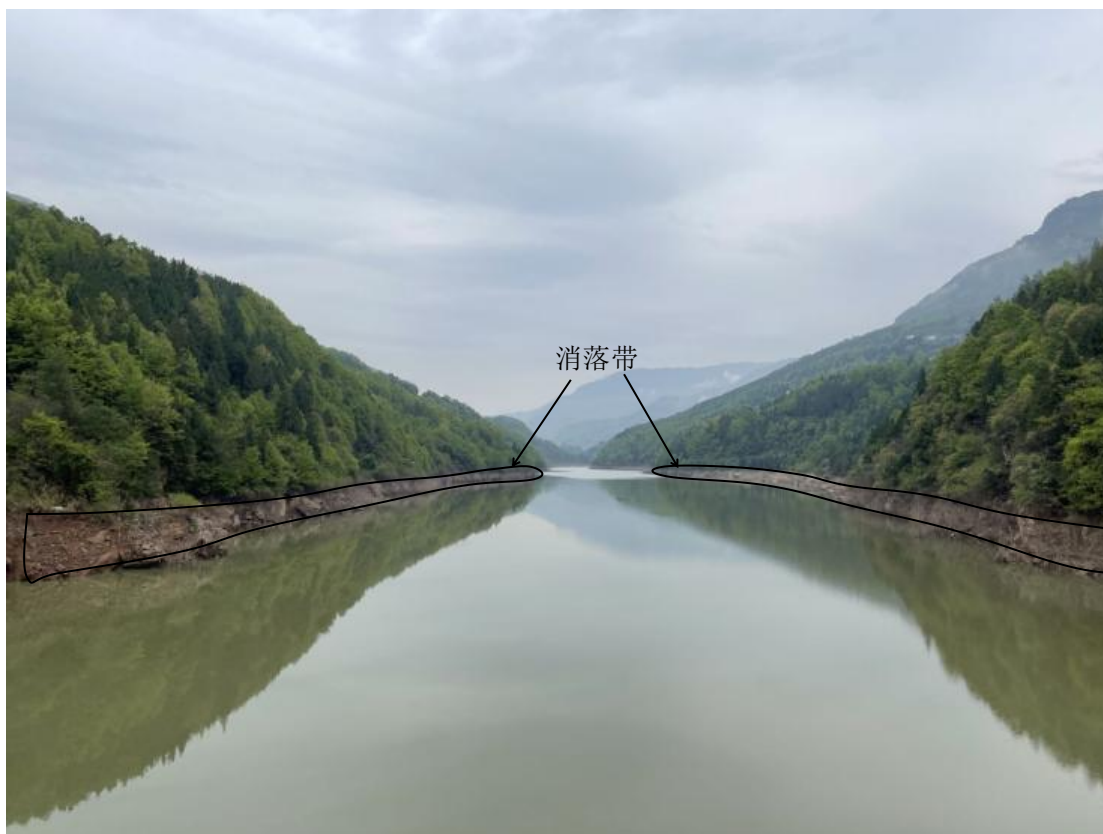
图 5.7-3 库区消落带现状
