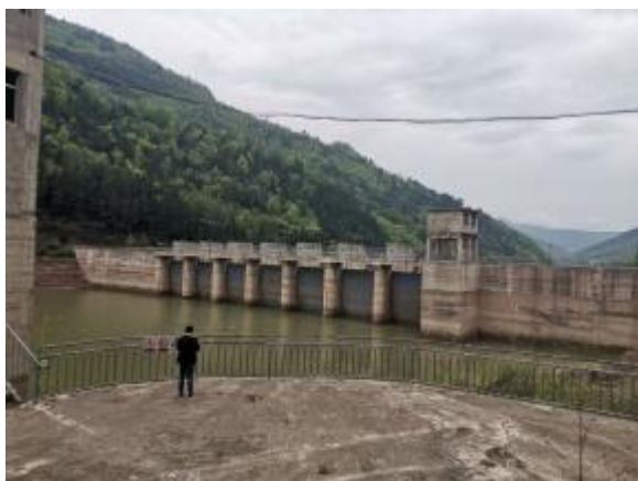
大坝及泄洪闸
